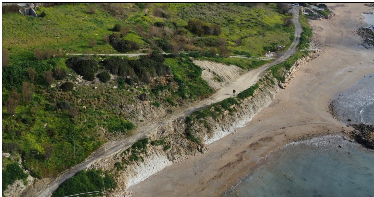
Figura 9 - Area in dissesto (vista da ovest).
